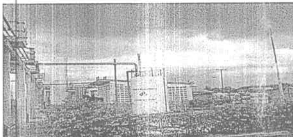
Fotografía No. 2 Futura área de remoción de manganoso.
